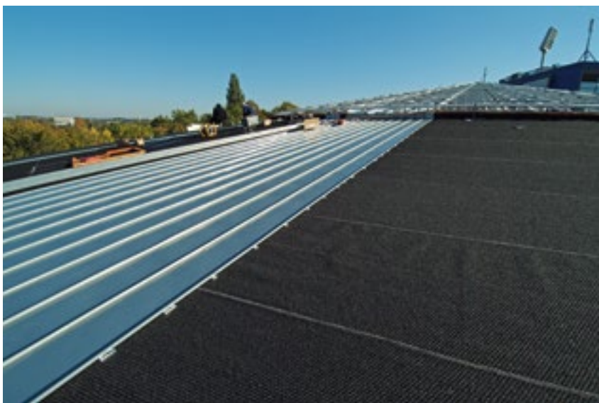
DELTA®-TRELA PLUS als Trennlage bei Metalldeckung.
