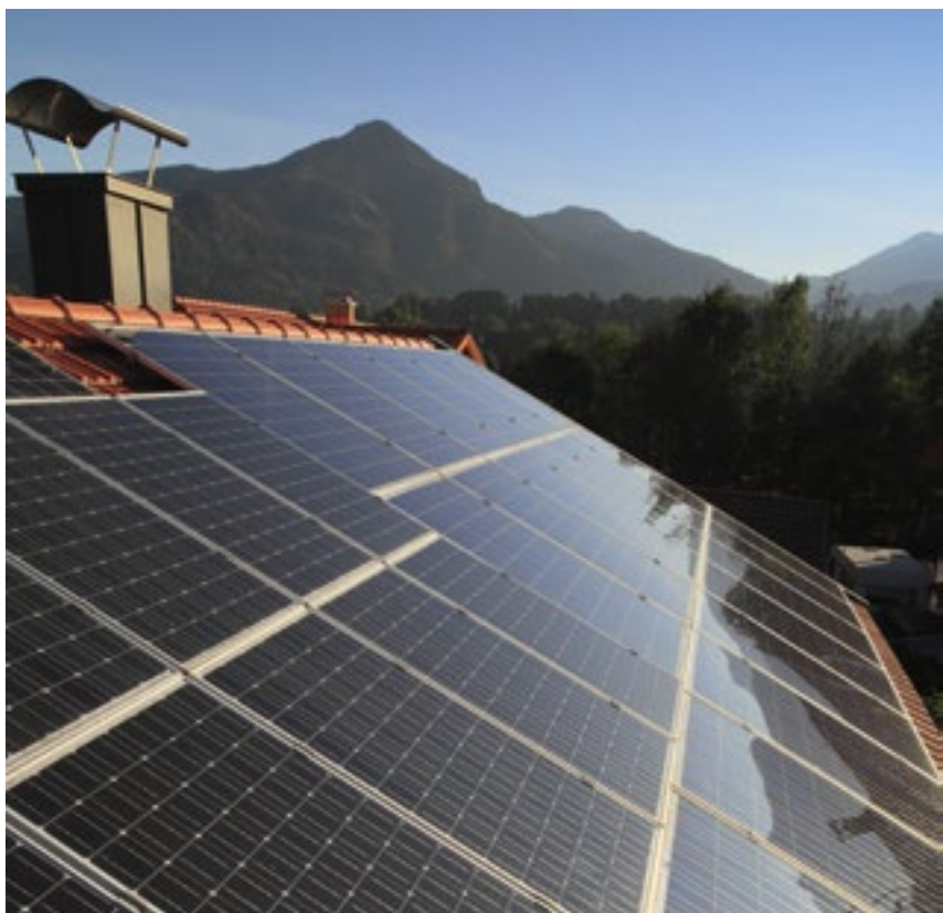
Ein Aufdach-System wie diese Photovoltaik-Anlage bringt erhöhte Anforderungen an die Dachkonstruktion mit sich.
