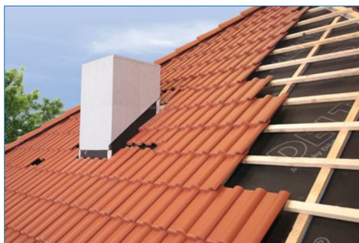
Obr. 6: po zakrytí krytinou je fólia chránená pred UV žiarením, avšak nie je chránená pred vysokou teplotou a pohybom vzduchu v priestore medzi fóliou a krytinou.
