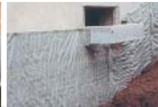
DELTA®-DRAIN udržuje spodní stavbu suchou a působí jako dodatečná tepelná izolace
