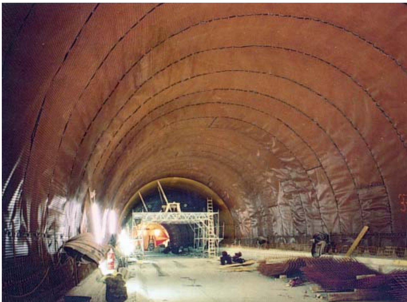
DELTA®-MS 20 má vysokou drenážní kapacitu a poskytuje vysokou jistotu.
