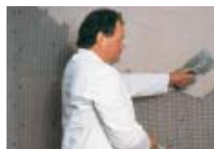
Omítka se jednoduše natahuje hladítkem
