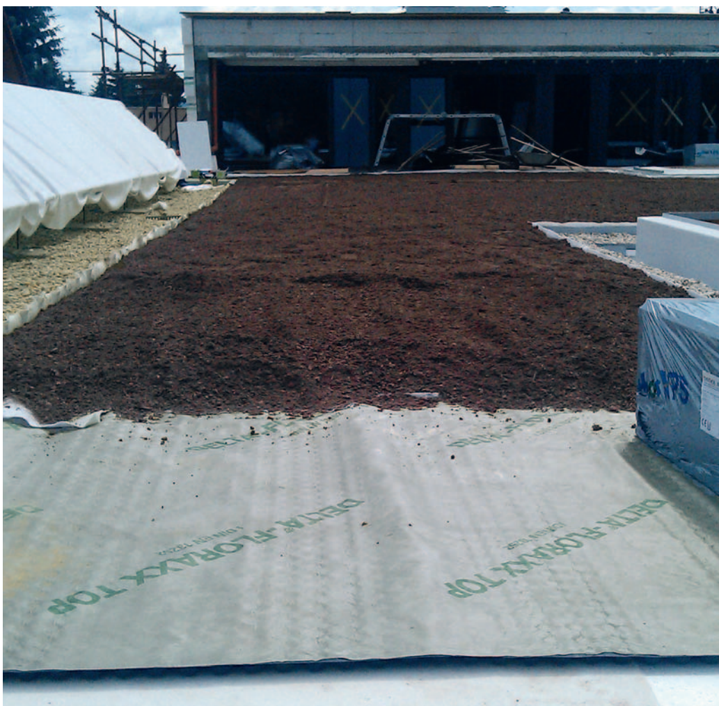
Rýchla, cenovo výhodná pokládka vďaka integrovanej geotextílii.
