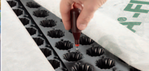
Pásky možno spojiť nitovačkou pribalenou ku každej palete.
