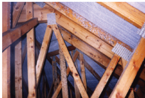
Рис. 1. Ошибка монтажа: намерзание конденсата на фанерном основании битумной кровли и подкровельной пленке, повреждение стропил плесенью
