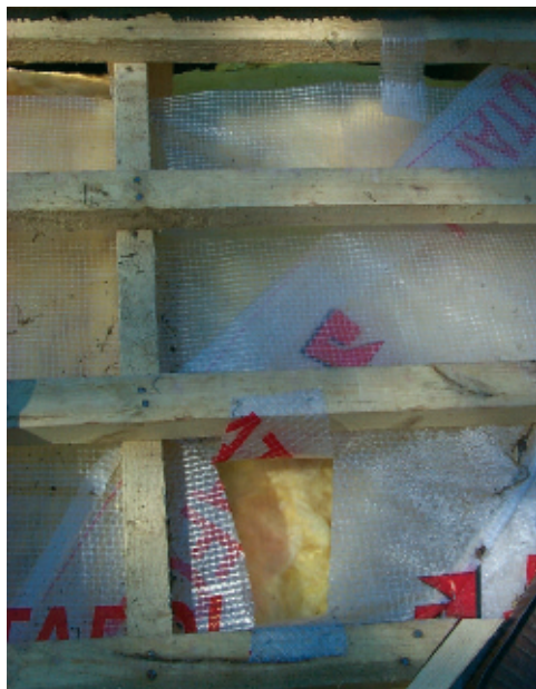
Рис. 10. Местное усиление вентиляции нижнего зазора: выполнение специальных проемов.
