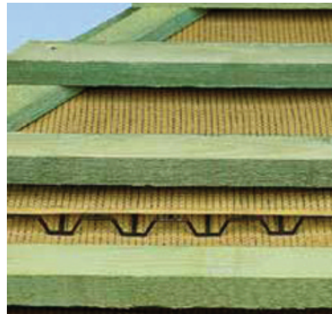
Рис. 9. Местное усиление вентиляции нижнего зазора: вентиляционный элемент нижней защитной пленки BRAAS; выполнение специальных проемов.
