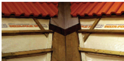
Рис. 11. Сплошной вентиляционный канал вдоль ендовы
