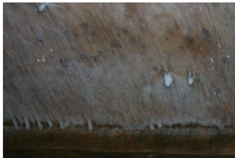
Рис. 1. Ошибка монтажа: намерзание конденсата на фанерном основании битумной кровли и подкровельной пленке, повреждение стропил плесенью
