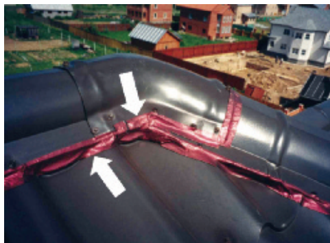
Рис. 5. Ошибка монтажа: герметичная заклейка конька и хребта
