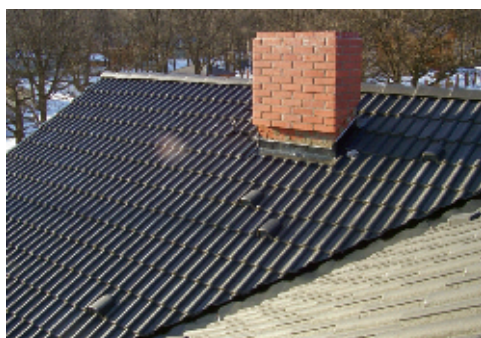
Рис. 12. Размещение вдоль ендовы аэраторов или вентиляционных черепиц
