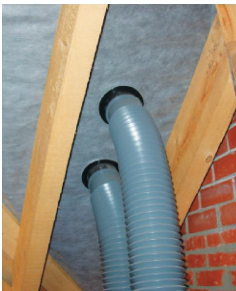
Рис. 8. Уплотнение вентиляционной проходки кровельной манжетой (BRAAS)
