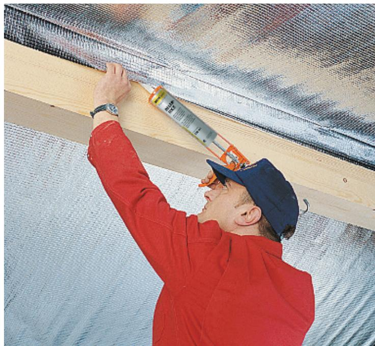
Рис. 3. Монтаж пароизоляции на закрытом прогоне
