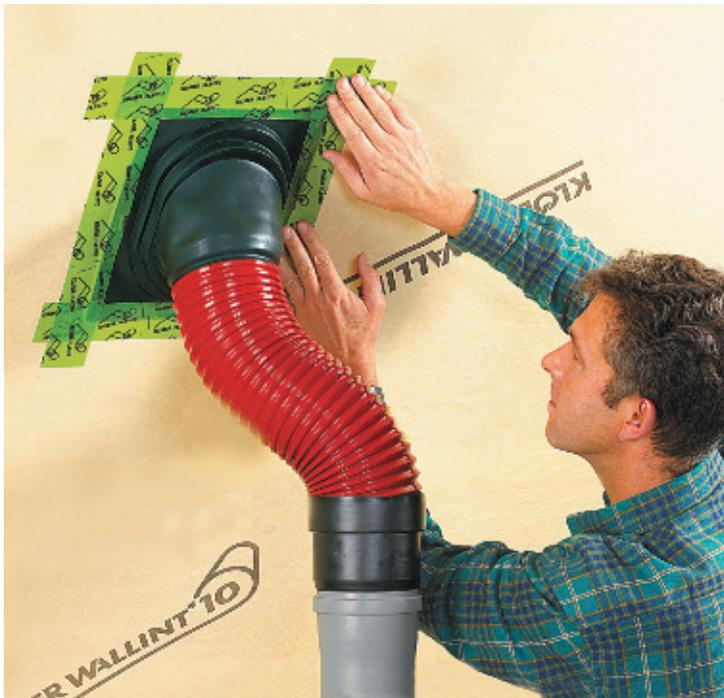
Рис. 5. Уплотнение вентиляционной трубы манжетой или скотчем (KLOBER)
