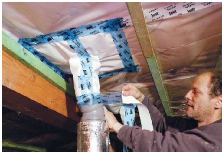
Рис. 7. Уплотнение канализационной трубы односторонней лентой (KNAUF)
