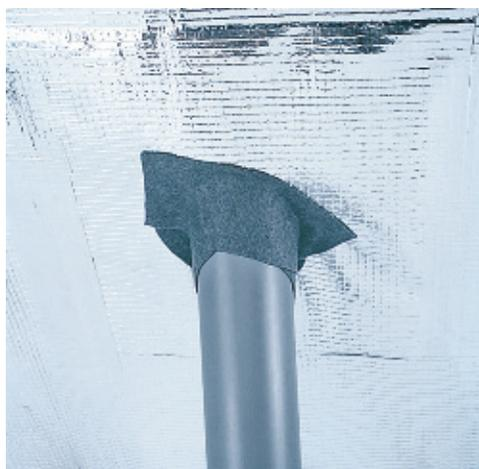
Рис. 6. Уплотнение вентиляционной трубы широкой лентой (DÖRKEN)
