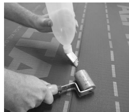
Монтаж DELTA®-ALPINA выполняется только по сплошному настилу.
