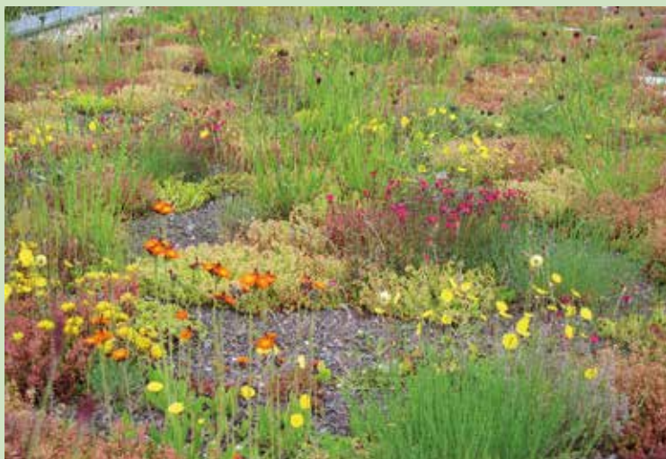
Пример крыши с экстенсивным озеленением
