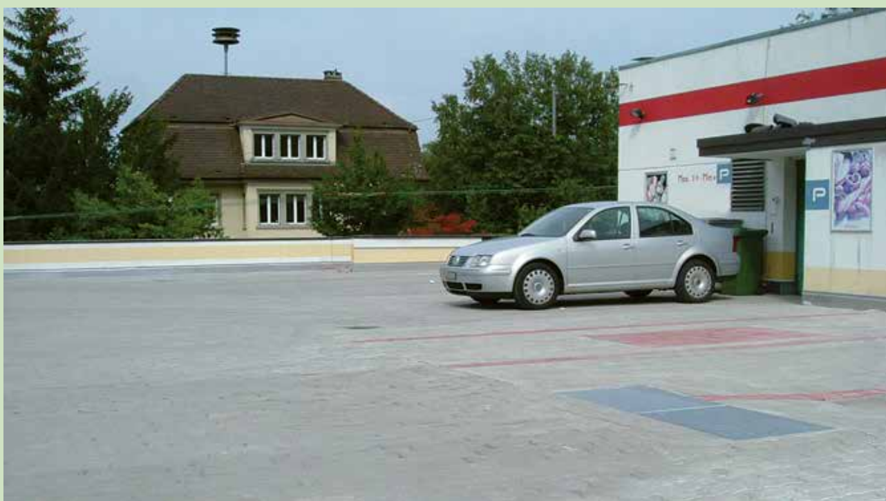
Пример проезжей части плоской крыши торгового центра из брусчатки
