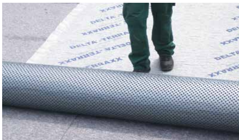
Мембрана быстро раскатывается по существующей гидроизоляции
