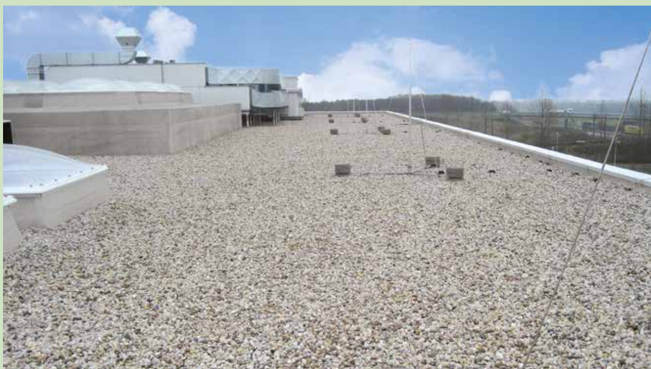
Балластная кровля торгового центра с DELTA®-TERRAXX
