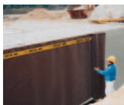
Защита гидроизоляции, замена бетонной подготовки
