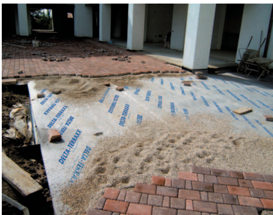
DELTA®-TERRAXX в качестве дренажного слоя под мощением брусчаткой
