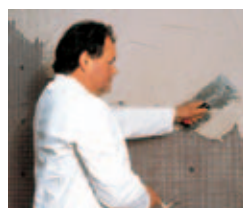
Ремонт влажных стен изнутри подвала. Восстановление тоннелей
