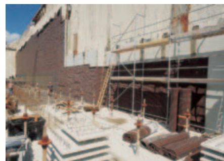
Установленные между фундаментной плитой и стяжкой пола листы DELTA®-MS 20 улавливают любую проникающую снизу воду, появляющуюся в результате подъема уровня грунтовых вод, и передают ее в дренажную трубу.
