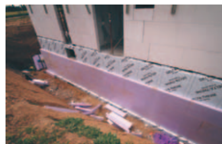
Утепление поверх гидроизоляции
