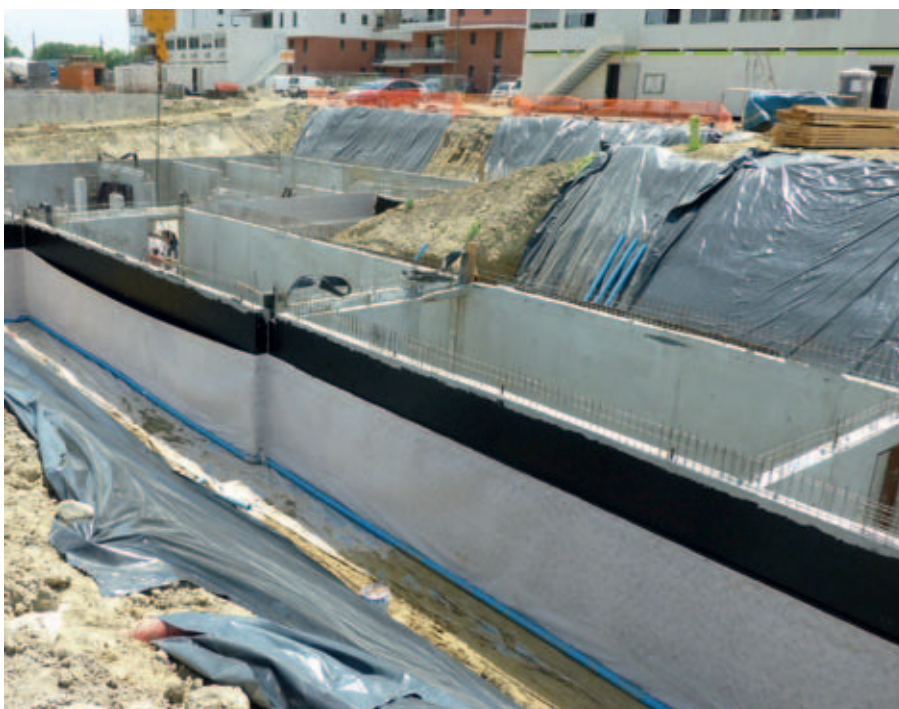
Защита и дренаж стены подвала многоквартирного дома.
