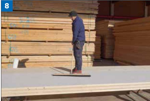
**(Fig. 8)** Utilizzando uno scopettone o una spazzola, applicare una pressione sull'area T2 della membrana spingendo eventuali bolle d'aria verso il bordo.
