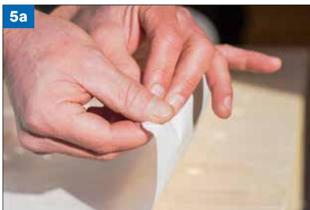
**(Fig. 5a e 5b)** **Suggerimento per la rimozione della pellicola:** piegare l'angolo della membrana, stringerlo tra le dita per un attimo rilasciando poi la pressione. La pellicola di protezione si potrà così staccare facilmente.
