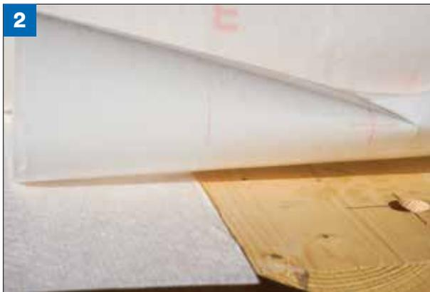
**(Fig. 2)** Allineare tutte le strisce successive tenendo conto della linea di sovrapposizione tratteggiata (12 cm). Se la membrana dovesse spostarsi leggermente, la sovrapposizione non deve essere comunque inferiore a 10 cm. Per il sormonto è necessario considerare la direzione del flusso d'acqua.
