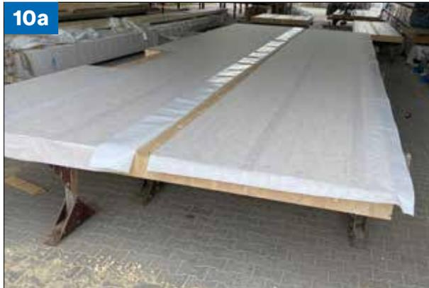
**(Fig. 10a e 10b)** Elementi prefabbricati: le sovrapposizioni vengono effettuate in ordine inverso. La pellicola più stretta (T1) non verrà rimossa fino all'installazione degli elementi prefabbricati in cantiere. Dopo aver rimosso la pellicola T1, lasciare passare un po' di tempo per far aderire al meglio le sovrapposizioni.
