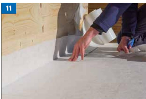
**(Fig. 11)** Per la connessione con gli elementi costruttivi in elevazione, si consiglia l'uso di una striscia di DELTA®-WOODIXX di larghezza minima 25 cm. La lunghezza di questa striscia deve essere scelta in modo da evitare qualsiasi difetto di rettilineità o l'applicazione su aree cave (mancanza del supporto). La sigillatura dei punti particolari come gli angoli, gli spigoli e gli elementi passanti deve essere eseguita mediante la banda adesiva DELTA®-FLEXX-BAND FG 80.
