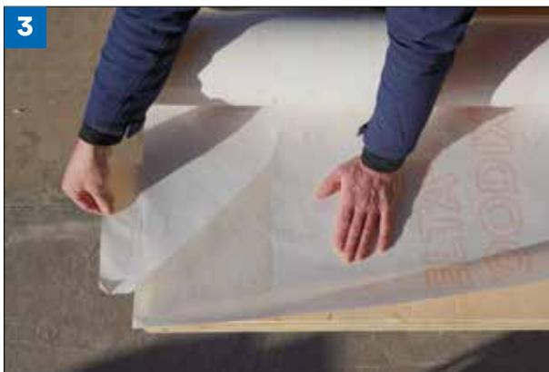
**(Fig. 3)** Posizionare il rotolo, rimuovere la pellicola removibile più stretta (T1) per una lunghezza di circa 50 cm, ripiegarla sotto la membrana fino a formare un triangolo disponendo la pellicola removibile (T1) perpendicolarmente alla membrana. È ancora possibile riposizionare e regolare l'allineamento della membrana fino a qualche minuto dopo l'applicazione senza il rischio di allungarla per ottenere una posa rettilinea e senza pieghe.
