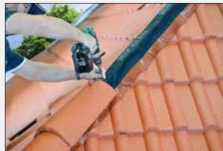
Fissare le tegole di colmo secondo le indicazioni del produttore. Le tegole di colmo devono comunque ricoprire la parte centrale permeabile all'aria del sottocolmo e sormontare sufficientemente gli elementi disposti sulle falde del tetto.
