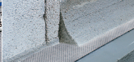
Keskeny holker a pincefal szigetelés csatlakozásához.
