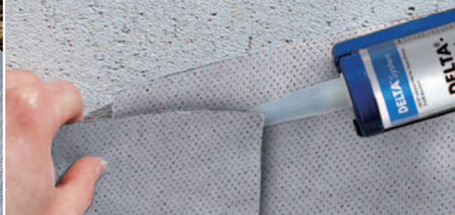
A falszigetelés összeragasztása DELTA®-THAN-nal.
