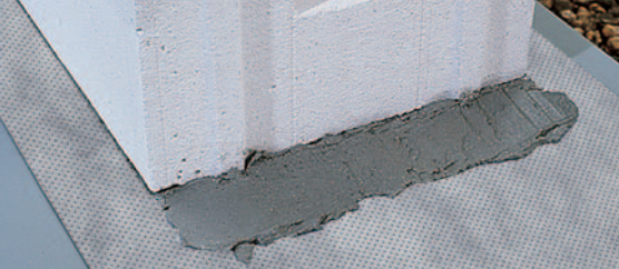
Oldalirányú túlnyúlás a szigetelés csatlakoztatásához.
