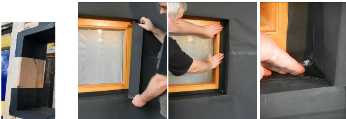
Figure 19 - Traitement des ouvertures
