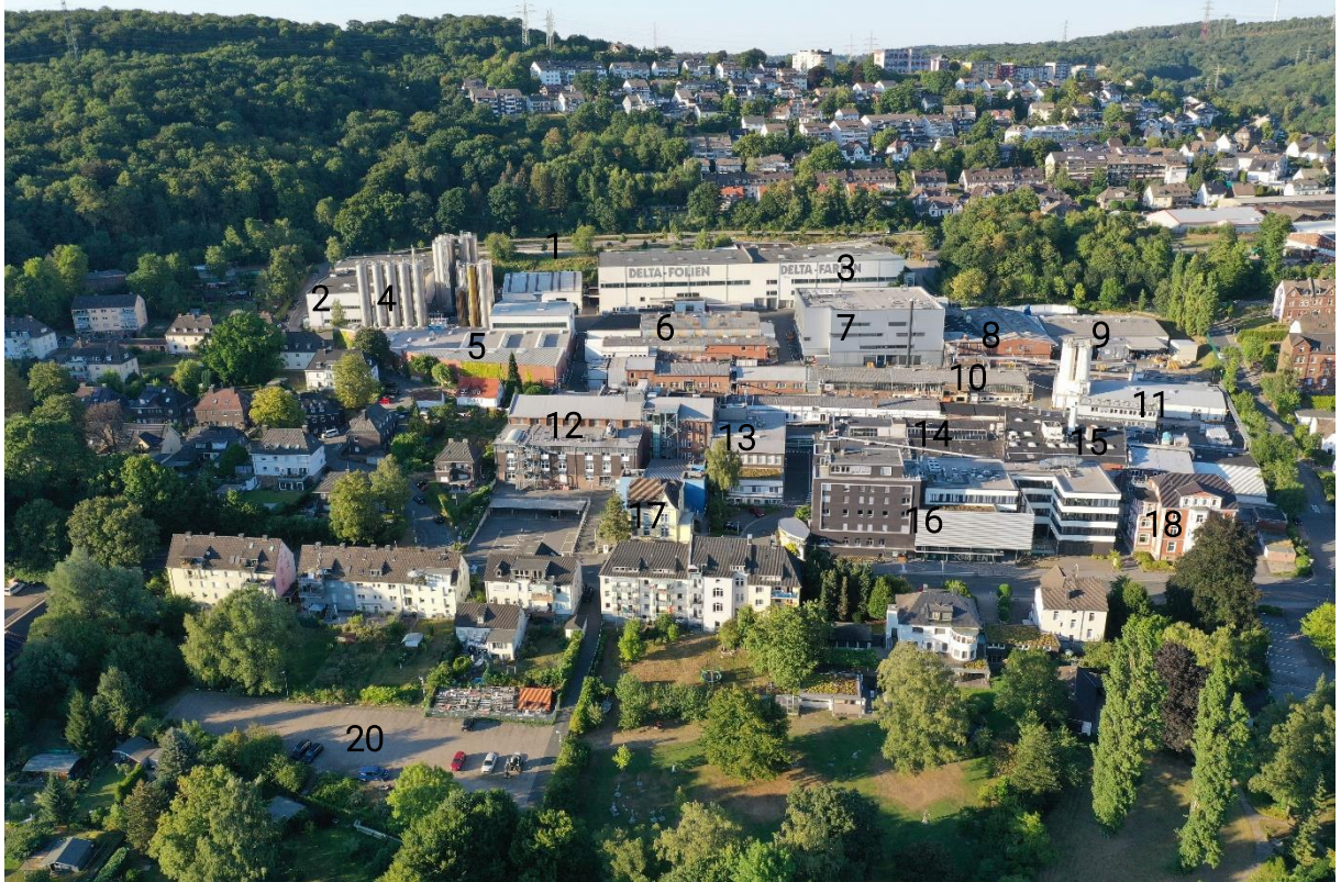
Abb. 5: Standort Herdecke, Wetterstraße
