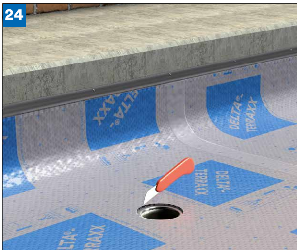
(Bild 24 und 25) Öffnungen für Dachabläufe vorsichtig ausschneiden (z. B. mit einem Klammesser). Achtung: Die Abdichtung darf dabei nicht verletzt werden! Anschließend die Bahn um den Dachablauf verlegen.
