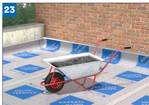
(Bild 23) Beim Einsatz auf erdüberschütteten Decken kann die verlegte Dränbahn zur Verfüllung direkt mit einer Schubkarre befahren werden. Bei vorauslaufender Schüttung von mind. 20 cm können die DELTA®-TERRAXX Bahnen in der Bauphase vorsichtig mit einem Radlader befahren werden.
