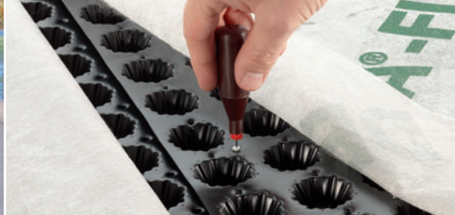
Pásky lze spojit nýtovačkou přiloženou ke každé paletě.
