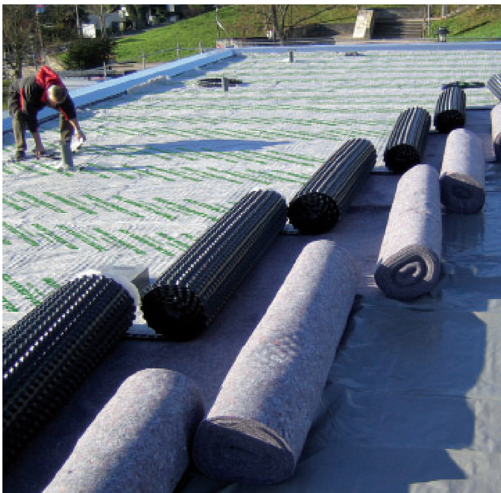
Rychlá, cenově výhodná pokládka díky integrované geotextilii.
