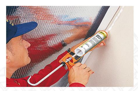
**Description:** colle pour les raccords aux murs des pare-vapeur DELTA®, application intérieure. Sans latte de compression
